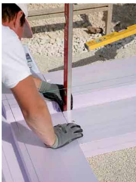
Die Ausrichtung des Systems erfolgt an einem Schnurgerüst.
