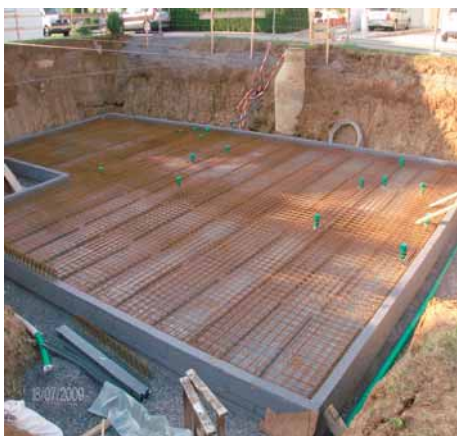
Auf das MAGU Atlas System wird zunächst eine PE-Folie sowie die Bewehrungsmatten nach statischen Erfordernissen gelegt.
