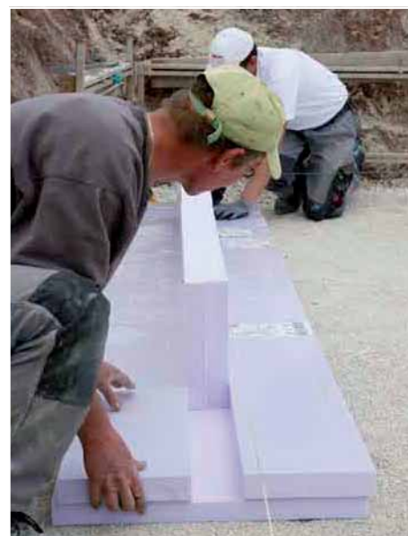
Die Schalungselemente werden in die Seitenteile gesteckt. Die Nuten gewährleisten absolute Wärmebrückenfreiheit.
