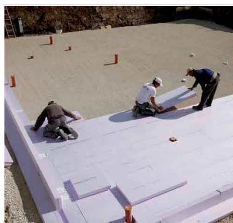
In kürzester Zeit steht das Grundgerüst und die Flächenelemente können verlegt werden.
