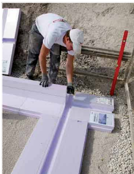
Gestartet wird die Verlegung, mit einem Ekelement, anschließend werden die Seitenteile angelegt. Zuvor muss die Baugrube mit Splitt planeben abgezogen und ausreichend verdichtet sein.
