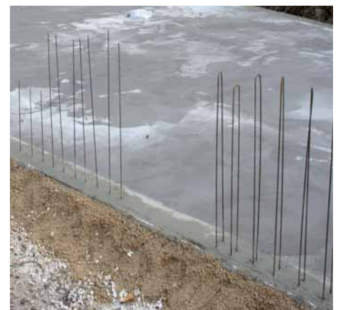
Anschlusseisen können ggfls. in den frischen Beton gesteckt werden.
